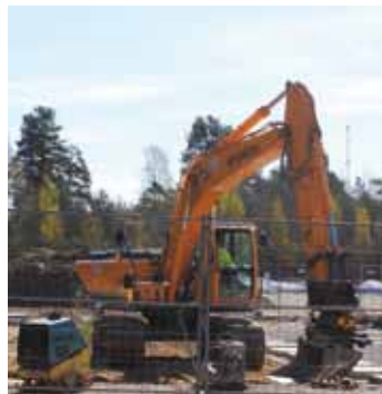
Arbetet i full gång med att förbereda marken till de nya skolhusen
